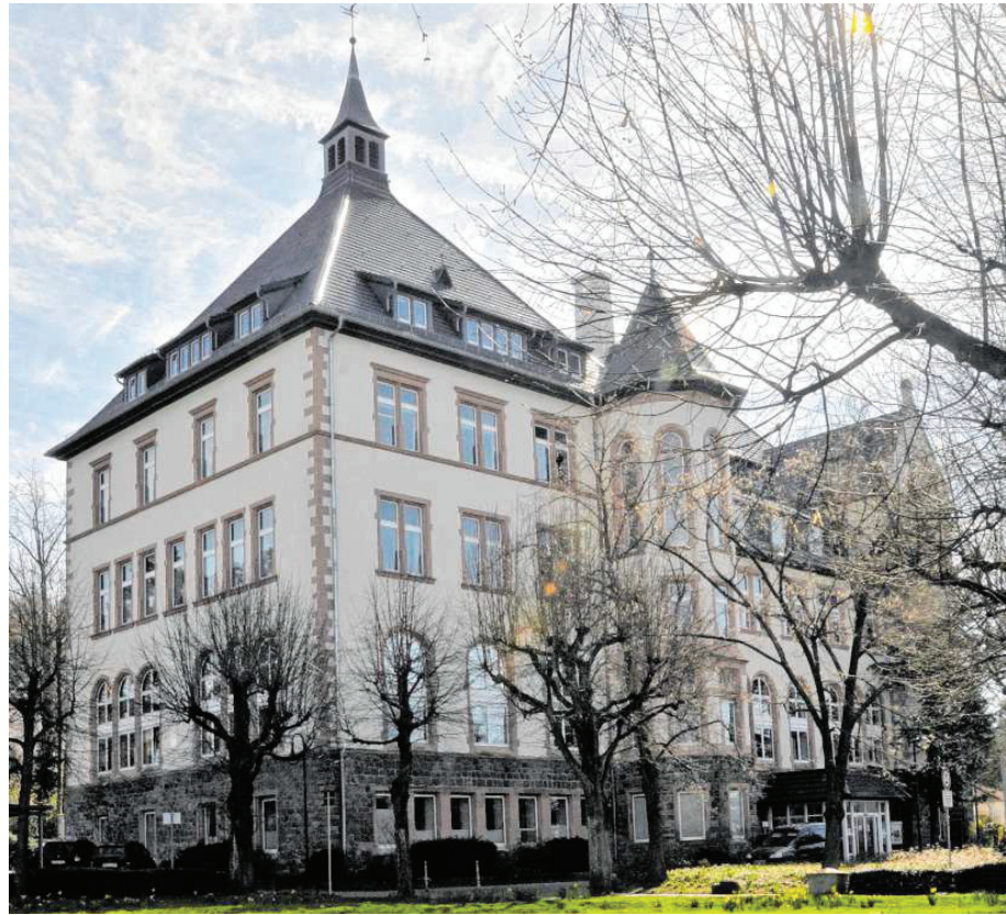
Das Bensheimer Rathaus: Wo heute die Mitarbeiter der Stadtverwaltung ihre Büros haben, waren früher Internatsschüler untergebracht – das Bischöfliche Konvikt an der Ecke Wilhelm-/Kirchbergstraße wurde im Jahr 1899/1900 gebaut. ARCHIVBILD: FUNCK
